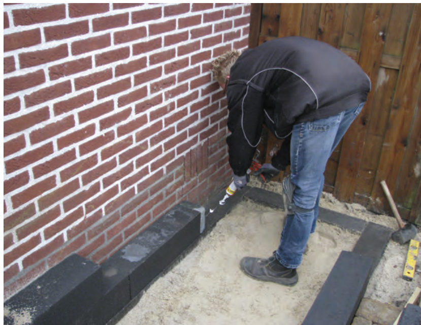
Het lijmen van palissadenblokken
