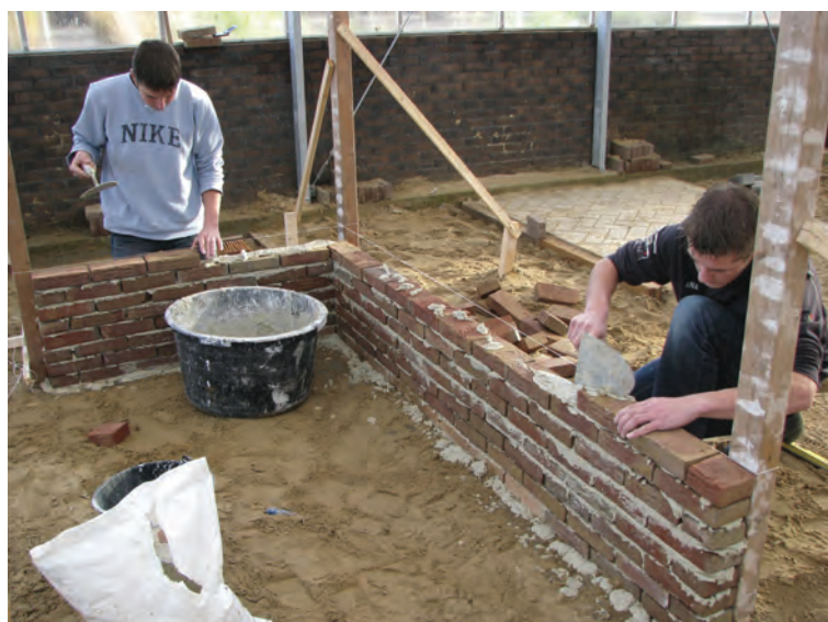
Hoveniers leren (tuin)muren metselen
